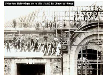
Ouvriers sur le toit de la gare de La Chaux-de-Fonds, vers 1901-1903
