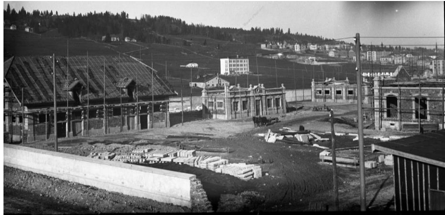
4. Les nouveaux abattoirs en construction. 1904
