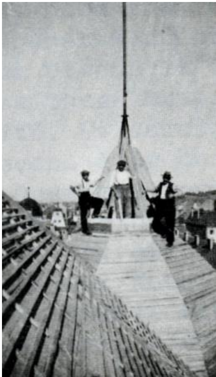
Figure 24: Toiture de la Maison du Peuple en construction.
