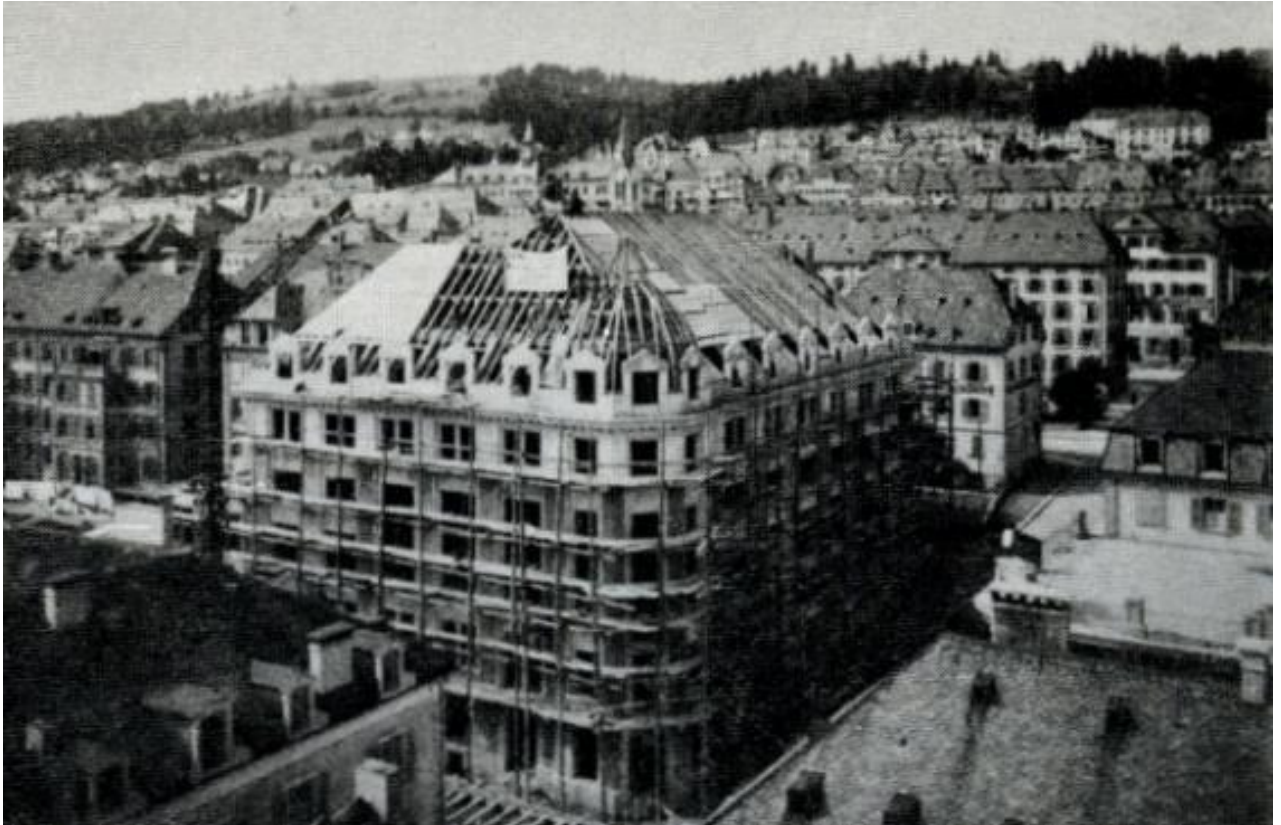
Figure 23: La Maison du Peuple en construction.
