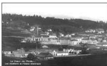
Les abattoirs et l'usine électrique (John Dubois, 1930)
